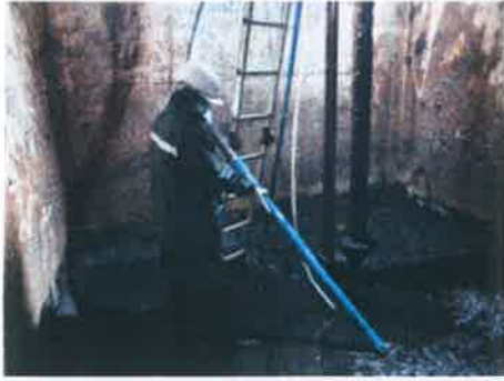
รูปที่ 2-13 กำหนดให้สูบตะกอนจากถังแยก ตะกอน
