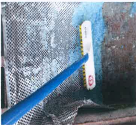
รูปที่ 2-15 ติดตั้งตะแกรงดักขยะที่บ่อพัก (สุดท้าย)
